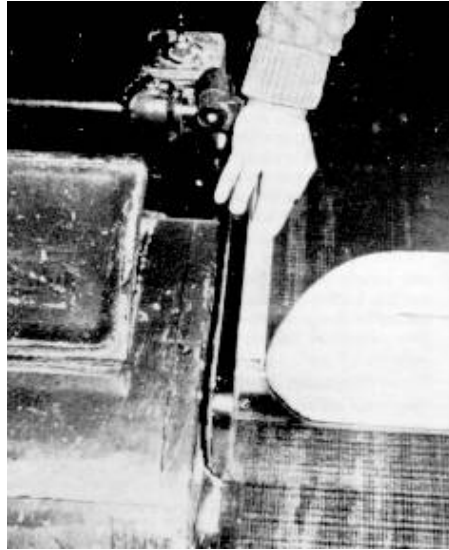
Vista del protector regulable del excedente del árbol portacuchillas no ocupado por la pieza
