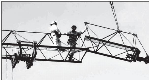
Figura 21. Montadores sujetos con EPI a la estructura
