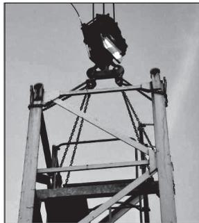
Figura 7. Eslingado correcto de componentes alargados
