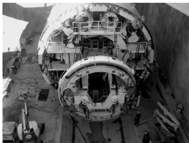
Figura 4. Montaje de una tuneladora
