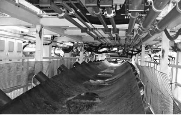
Figura 2. Cintas transportadoras de material excavado
