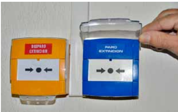
Figura 4. Pulsador de disparo manual del sistema (amarillo) y pulsador de bloqueo o anulación del disparo (azul)
