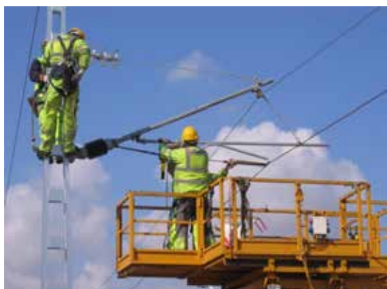
Figura 8. Montaje de ménsulas.
