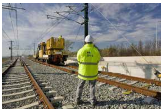
Figura 9. Montaje de aisladores.
