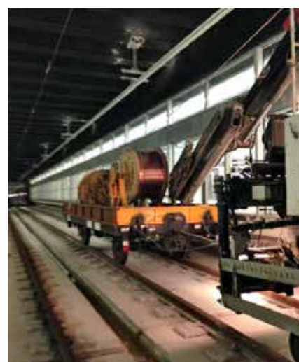
Figura 10. Tendido de conductores.
