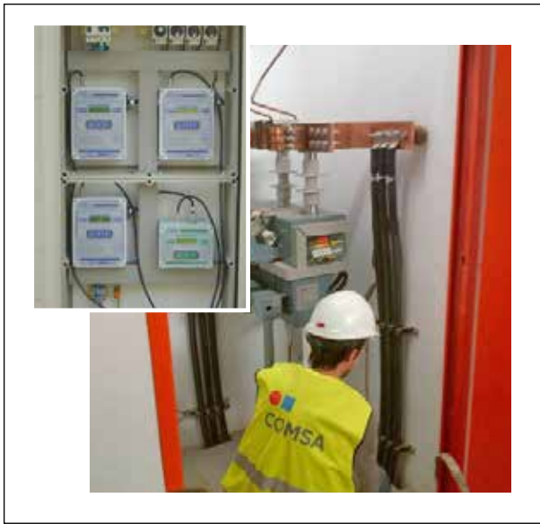
Figura 11. Ejecución de instalaciones de armarios eléctricos.
