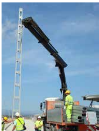
Figura 5. Colocación de poste.
