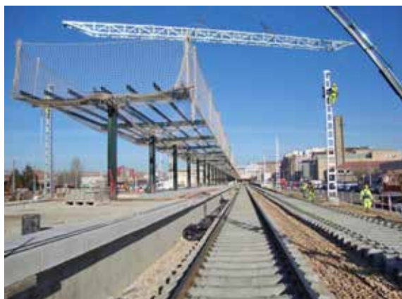
Figura 6. Colocación de pórtico.
