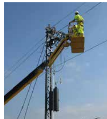
Figura 7. Montaje de un equipo de compensación.
