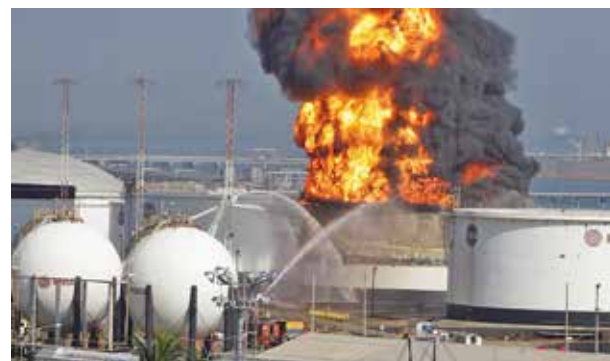
Figura 3. Ejemplo de daños: incendio en una instalación industrial de almacenamiento producido por un rayo
