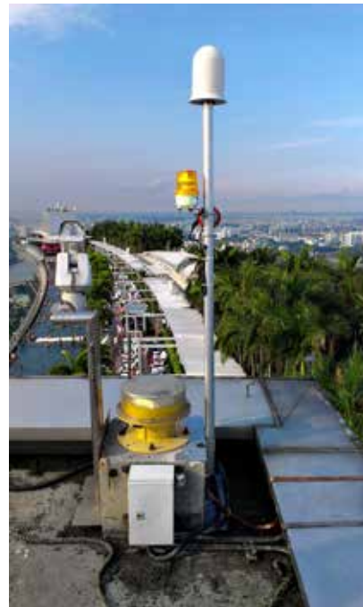
Figura 7. Detector de tormentas instalado sobre un edificio con zonas abiertas
