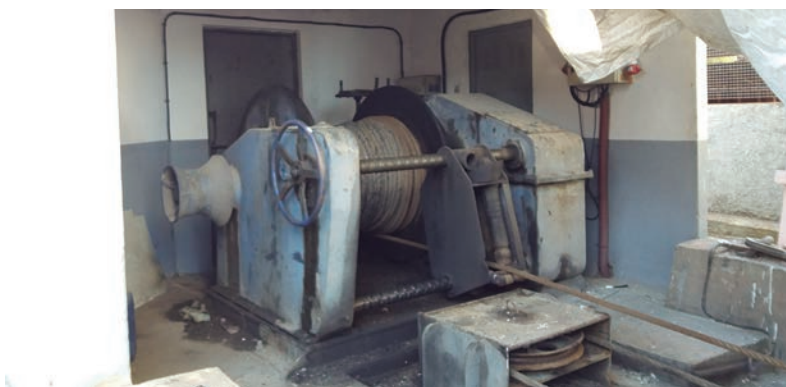
Cabrestante en el interior de una caseta
