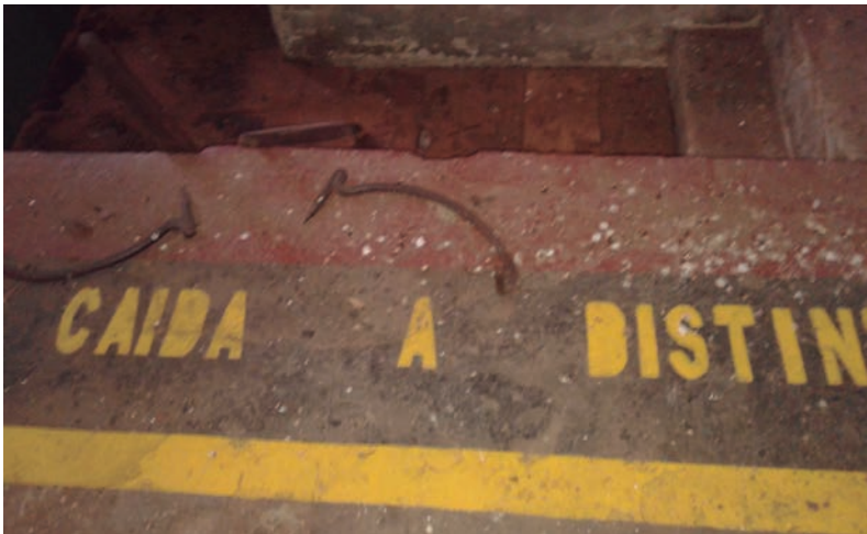
Señalización del foso
