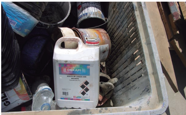
Recipientes con restos de productos almacenados incorrectamente al aire libre
