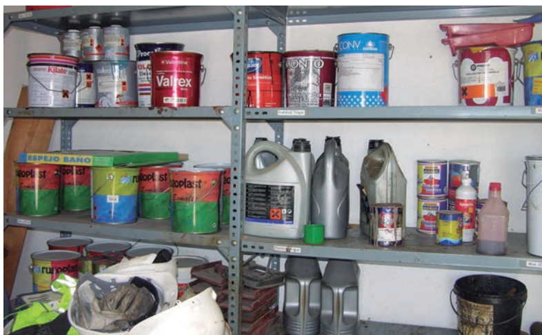
Almacenamiento de productos en estanterías, sin cubeto de retención
