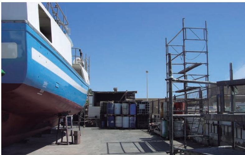
Andamio para acceso a embarcaciones
