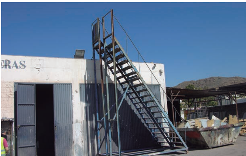
Escalera de acceso a embarcaciones
